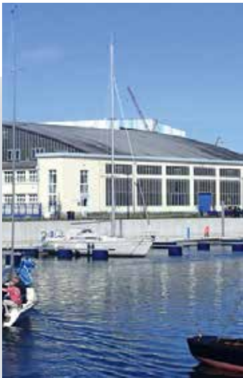
Firmengebäude der Yachtwerft Ostsee GmbH am Westhafen 3A
