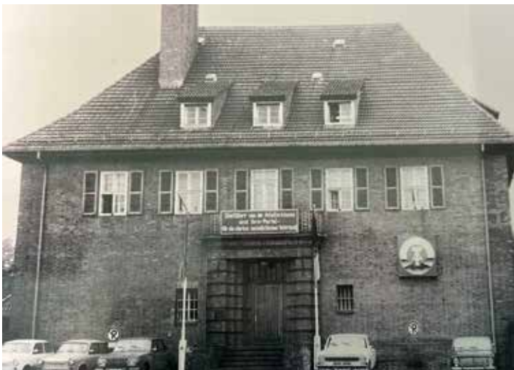
Gebäude Dr.-Leber-Straße 2 um 1954 bis 1990
