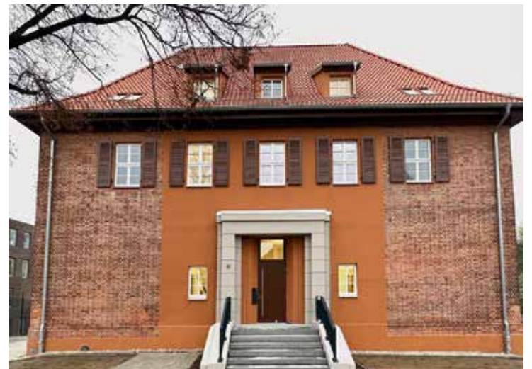
Gebäude Dr.-Leber-Straße 2 nach der Sanierung im Dezember 2022
